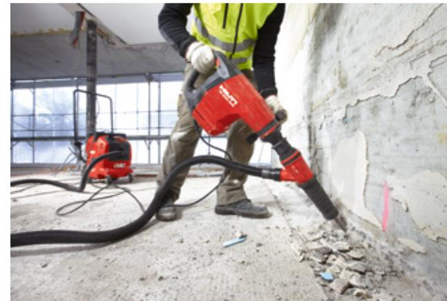
**Dank des ergonomischen, kompakten Designs und einer verminderten Vibration ermöglicht der Abbruchhammer TE 800-AVR ein längeres präzises Arbeiten. Das integrierte Absaugsystem vermindert Staubemissionen um bis zu 95%. Verschleißteile können einfach ausgetauscht werden, sodass Reparaturen auch selbst durchgeführt werden können. Am Ende der Nutzungsdauer kann das Gerät zum Recycling an den Hersteller zurückgegeben werden.**
